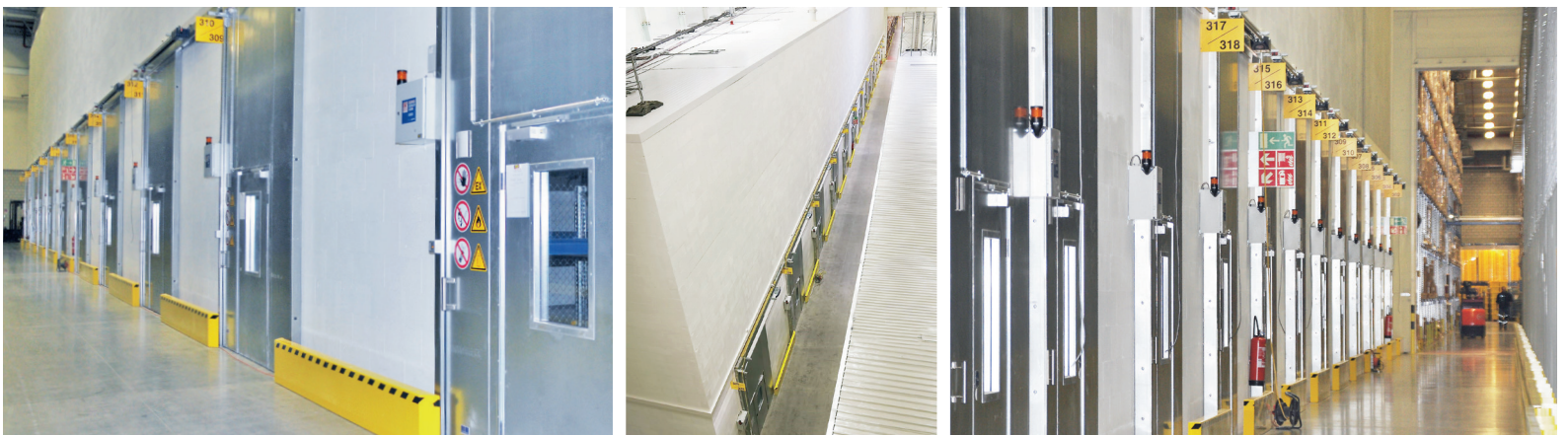
Der technische Raum umfasst 1600 Lagerplätze.
